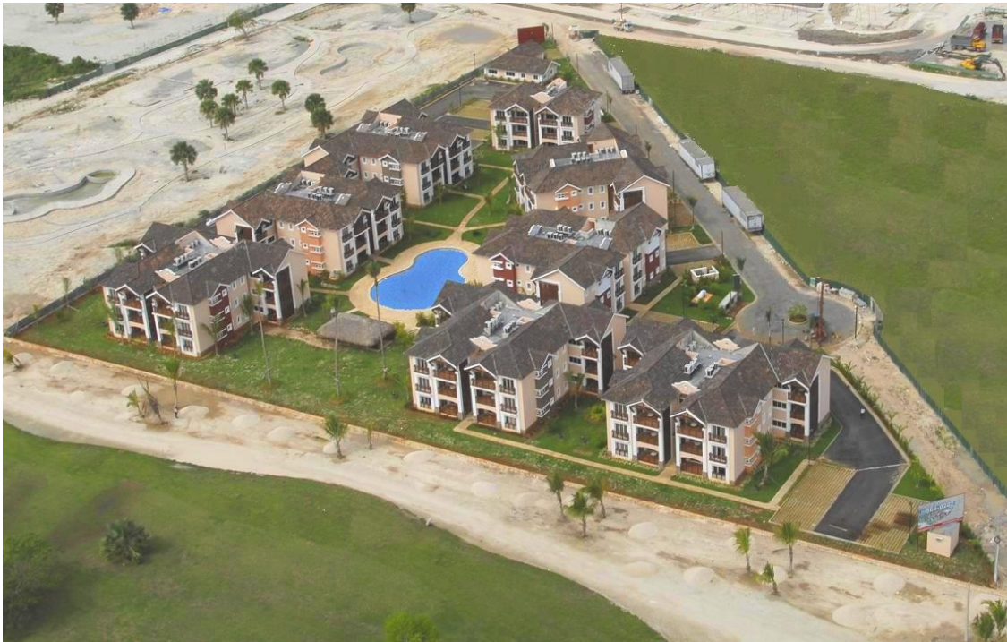
Vista de Conjunto
