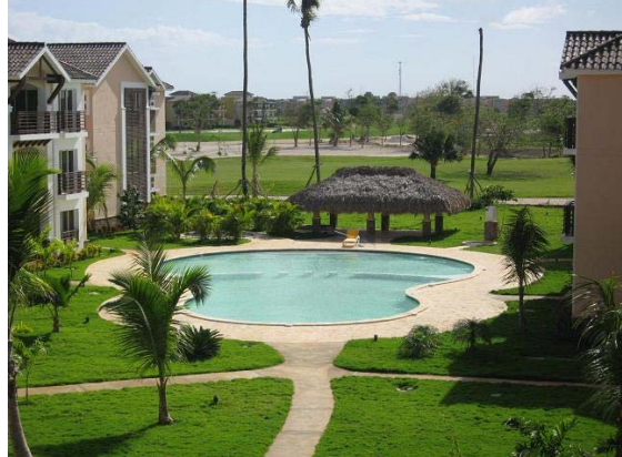
Vista de la piscina desde 3er nivel bloque A (Oct 2007)
